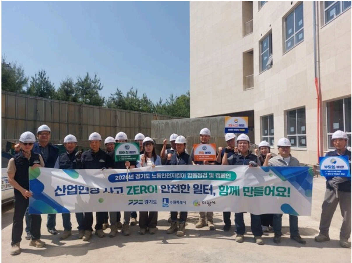
수원특례시와 의왕시가 노동안전의 날을 맞아 5월14일 영통구 이의동 노유자 의료시설 신축공사 현장에 서 합동 안전점검을 실시했다. (사진=수원시)
